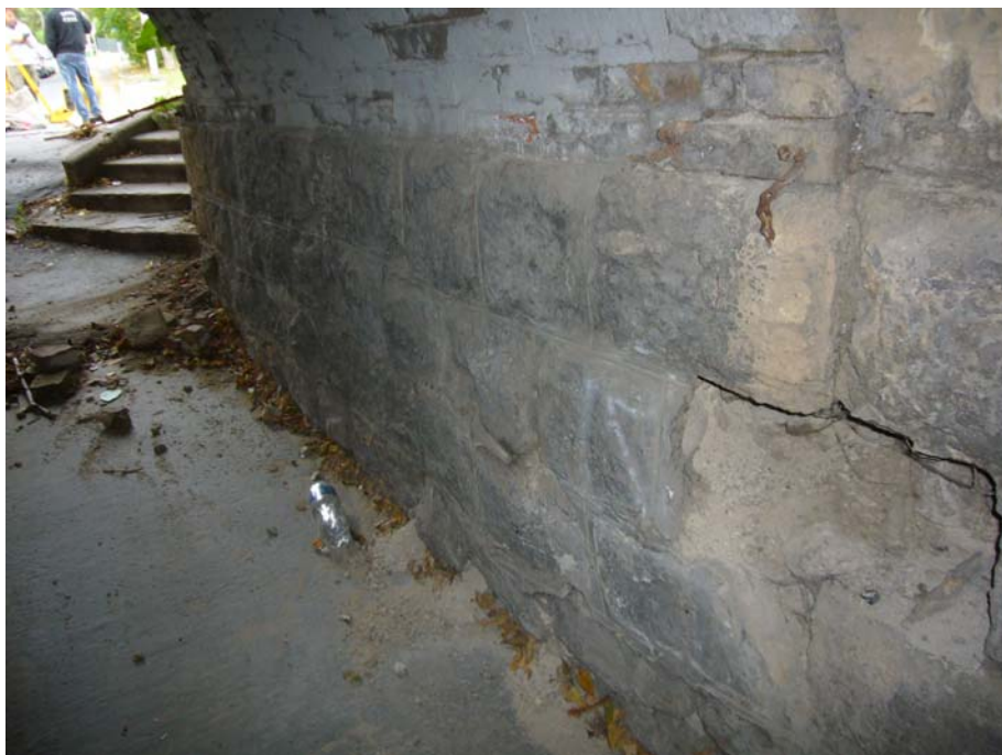
5. sz. kép Falazati hiány az eredeti műtárgy toldásánál
